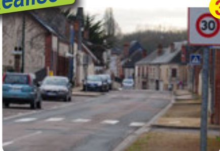
Création d'un passage protégé PMR à l'école maternelle.
