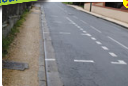
Création de places de parking en haut de la rue Pierre Juglar.
